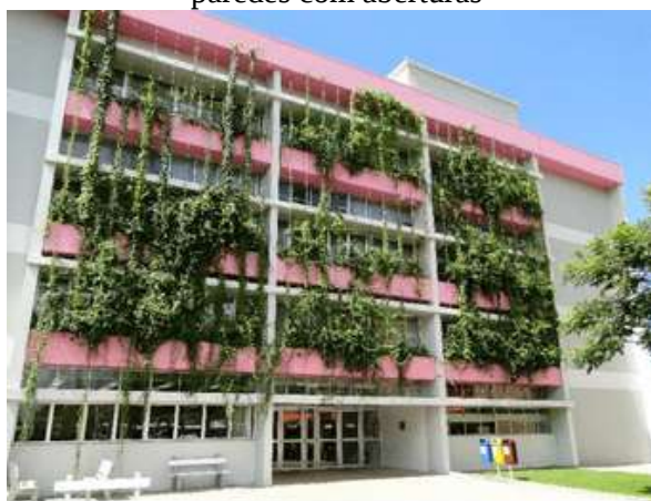
Figura 03: Vegetação sobre guias afastadas das paredes com aberturas
