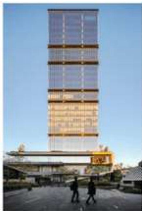
Figura 14: Fachada com sistema de brises
