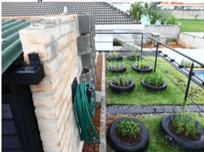
Figura 10: Casa 63 – telhado verde - horta
