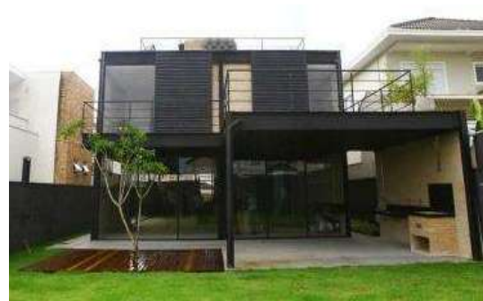
Figura 09: Casa 63 – Fachada posterior
