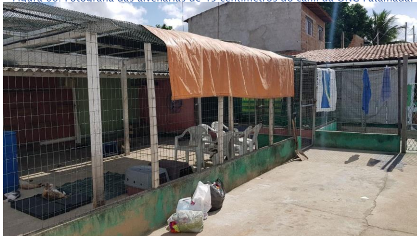
Figura 06: Fotografia das alvenarias de 45 centímetros do canil da ONG Patamada.
