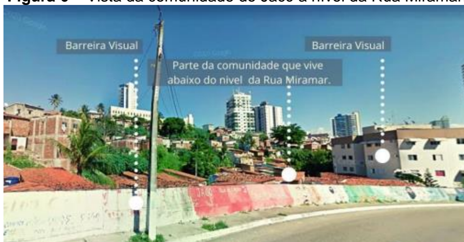
Figura 6 – Vista da comunidade do Jacó a nível da Rua Miramar.
