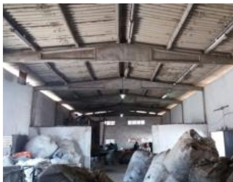
Figura 04 - Foto interna do galpão de prensagem, mostrando as vedações, os suportes do telhado e as aberturas para a área externa.
